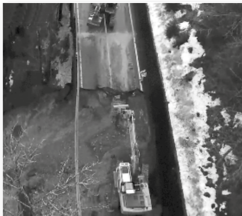
Strassenabbruch – Arbeit am Freitag vor dem Rennen
